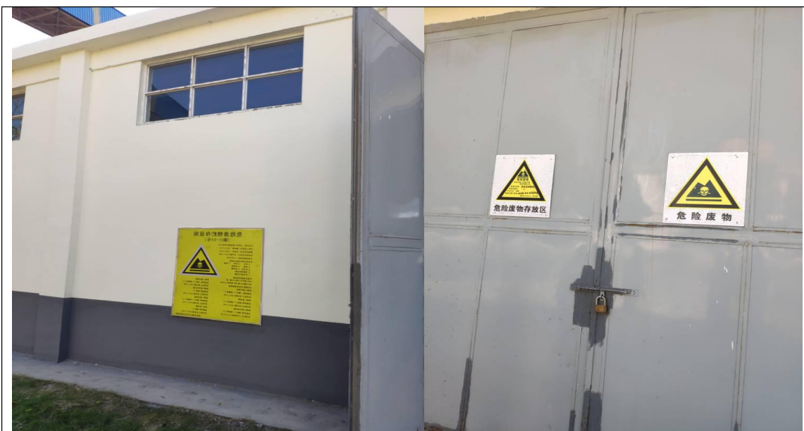
危险废物储存仓库外部图片
