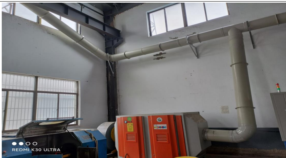
UV 光氧催化废气处理装置
