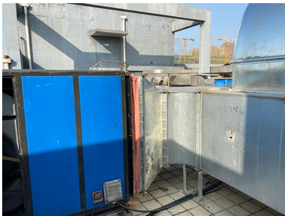
NF 溢出动物房废气处理设施 FQ-4 排气筒
