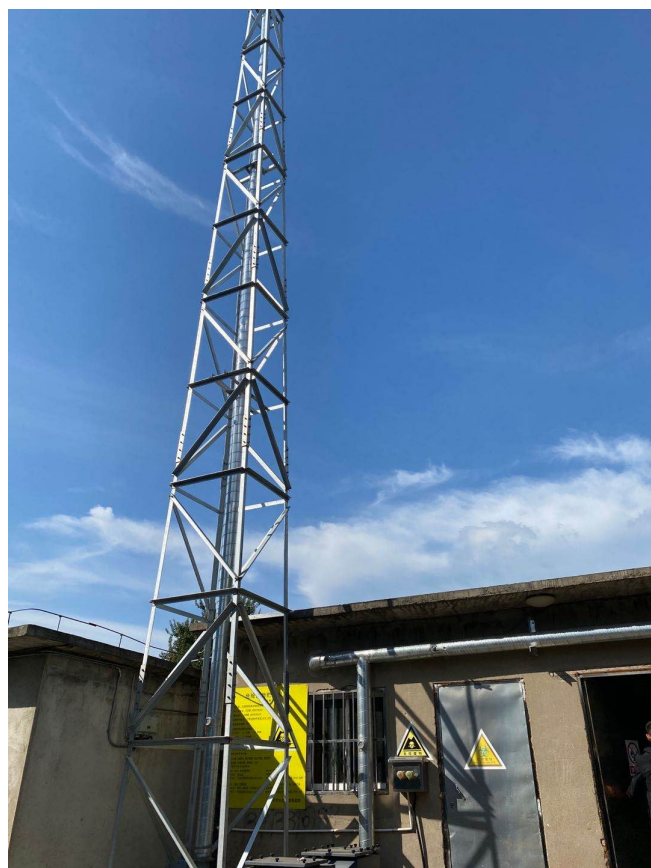
危废仓库废气处理设施 FQ-7（检测报告中为 FQ-11）排气筒
