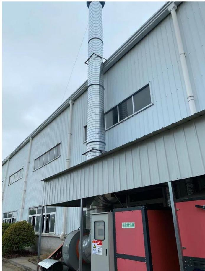
图 2-5 挤出工序、注塑工序活性炭吸附+催化燃烧（脱附再生）装置装置及排气筒
