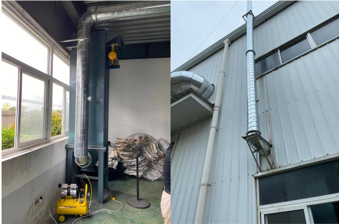
图 2-4 切割打磨工序布袋除尘装置及排气筒
