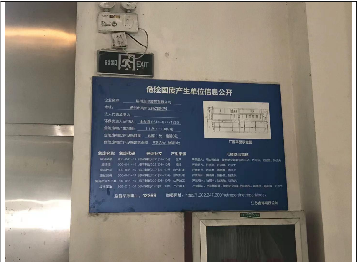
本项目危废贮存间
