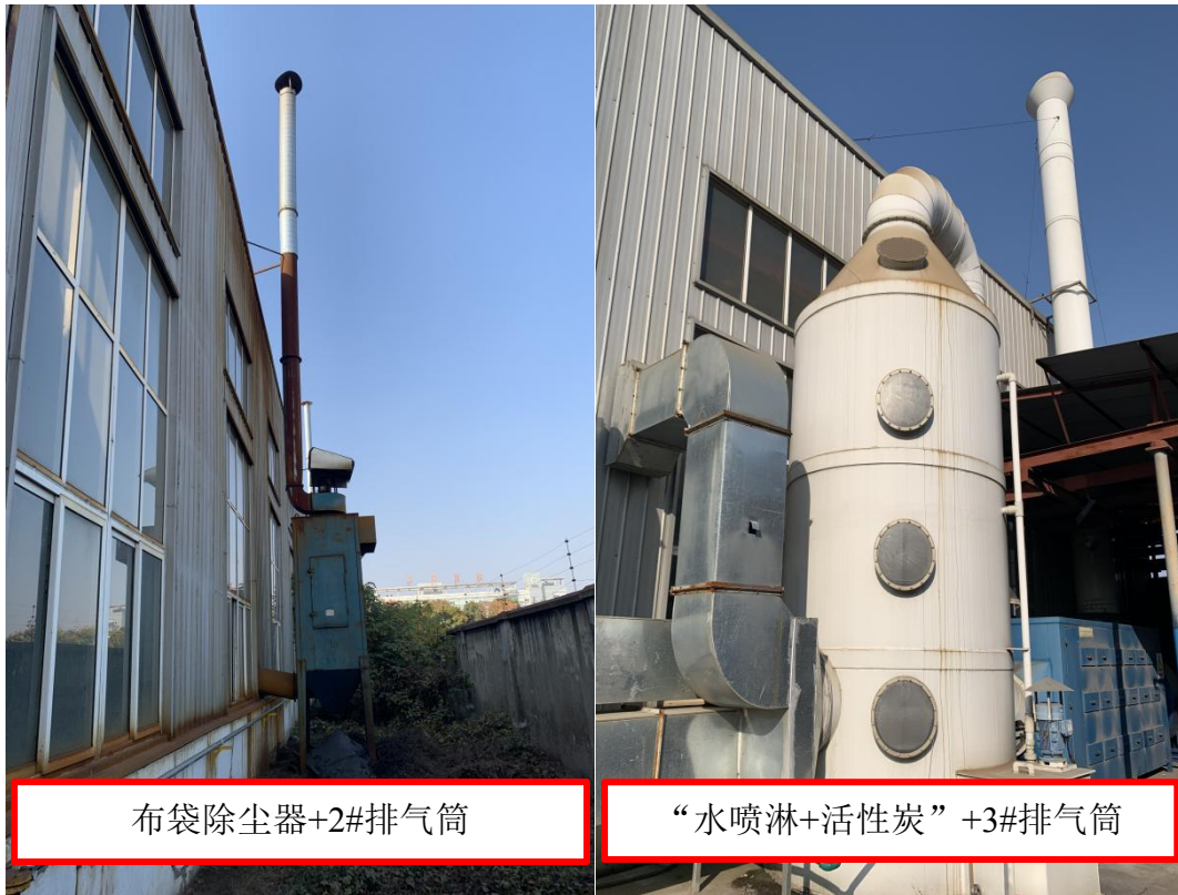
废气处理设施及排气筒图片
