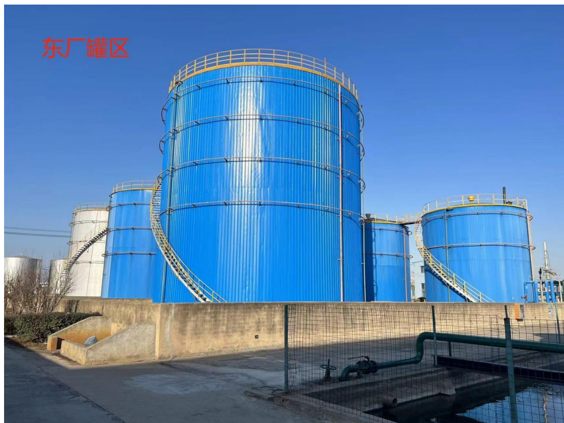
图 3-10 东厂罐区地面硬化
