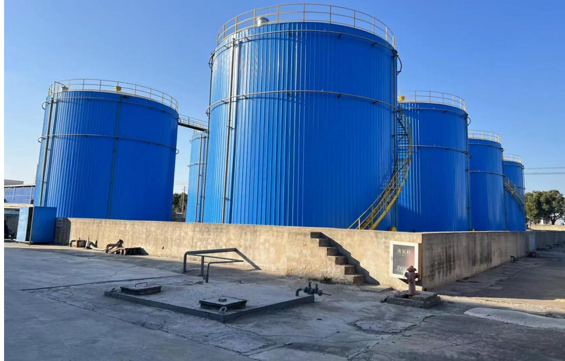
图 3-11 修复后西厂罐区
