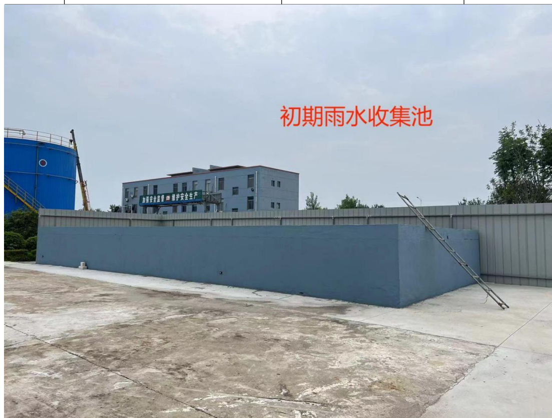
图 3-8 初期雨水收集池
