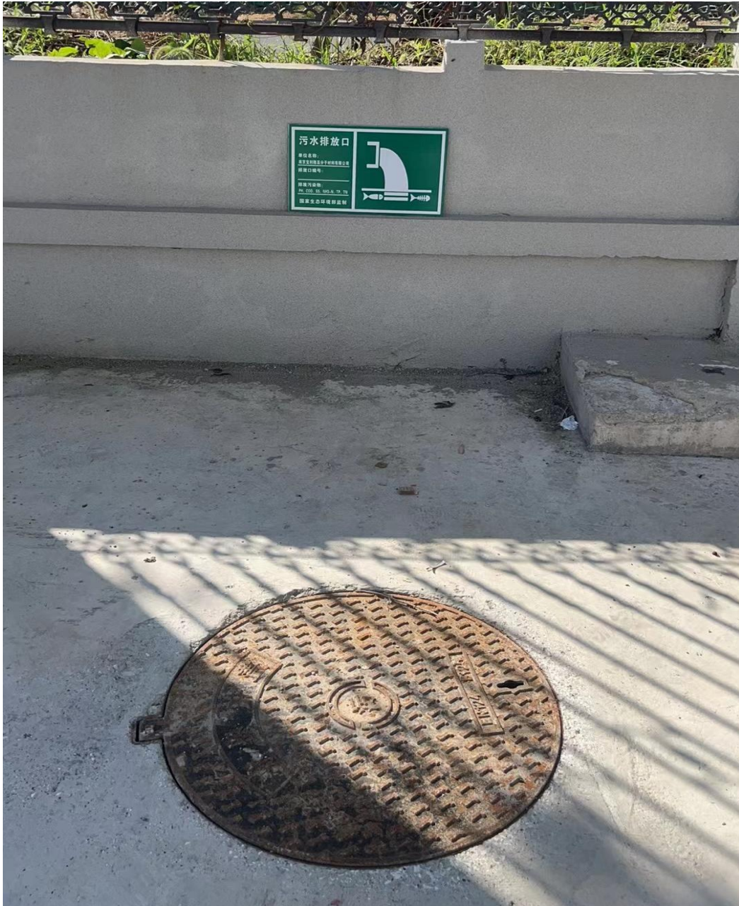
污水排放口标识牌
